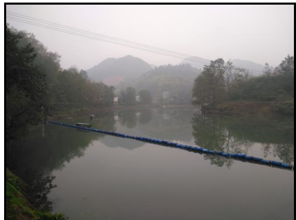
红卫水电站发电库区
