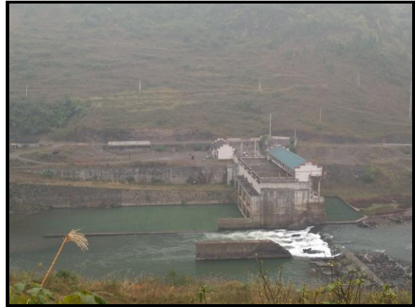
金银山水电站发电厂房
