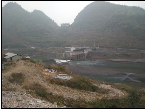
金银山水电站大坝
