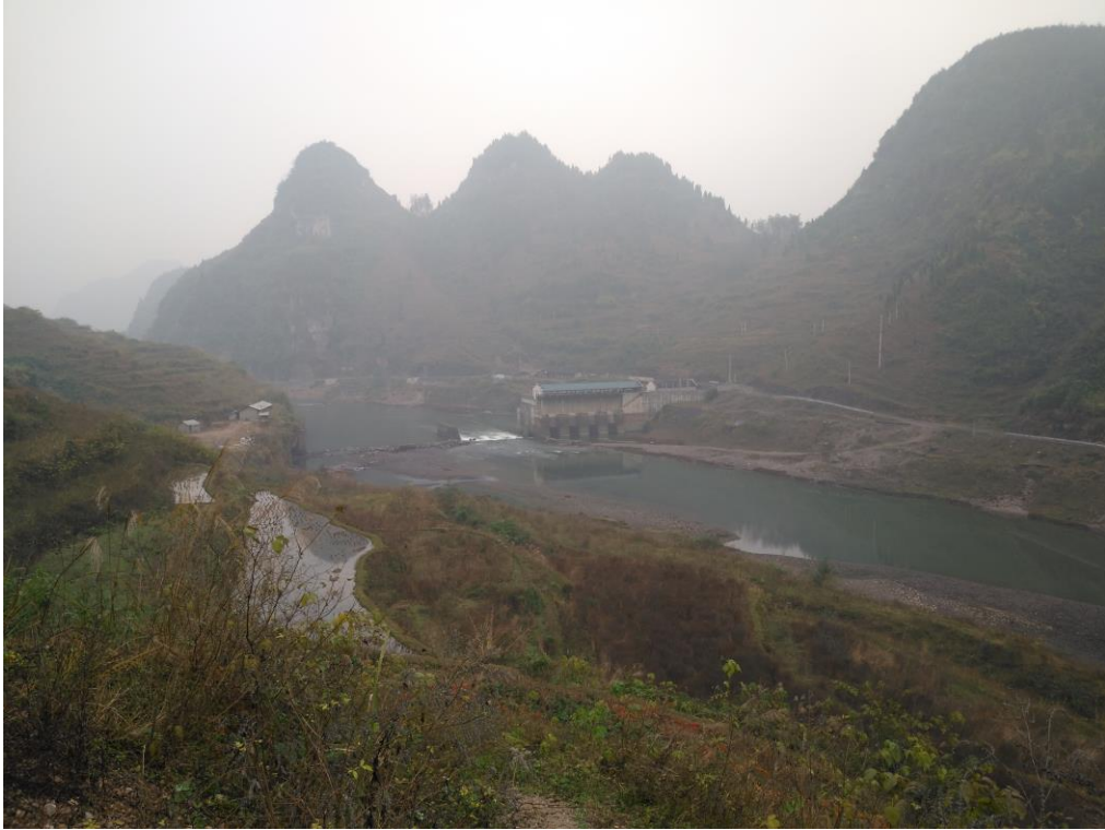
金银山水电站现状 1
