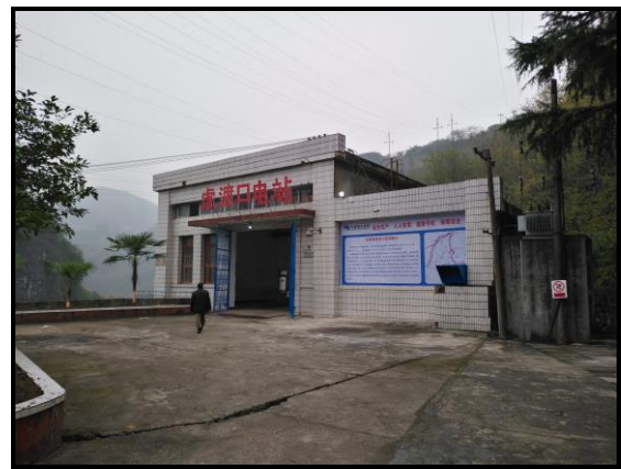
虎渡口水电站发电厂房
