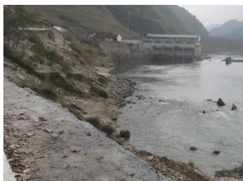
2#渣场（电站大坝下游右岸）
