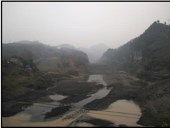
虎渡口水电站大坝
