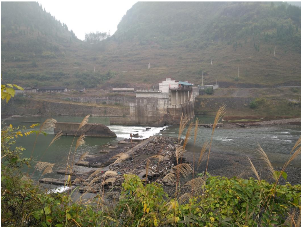
金银山水电站现状 2
