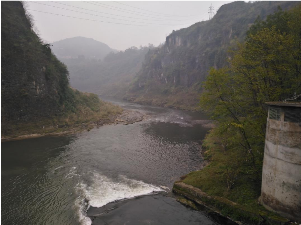
金银山水电站库尾（尾水接虎渡口水电站退水口）
