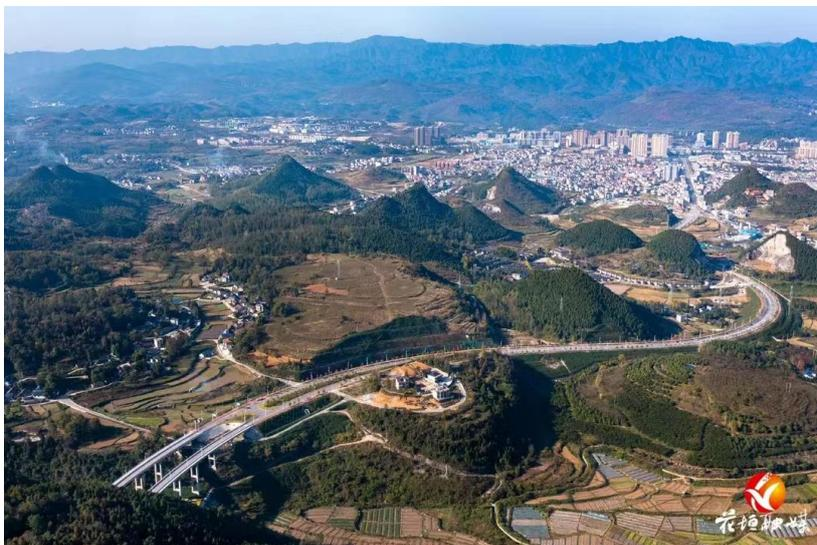
道路全长 7.361 公里，按市政道路标准建设，路基总宽 32/24 米，控制性工程为 999 米长的紫霞隧道，连接县城区、机场、高铁、农
